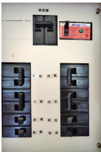
★ 圖 C-45a 配電盤外觀圖
